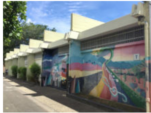
Façade Nord Est
