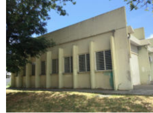
Façade Sud Est
