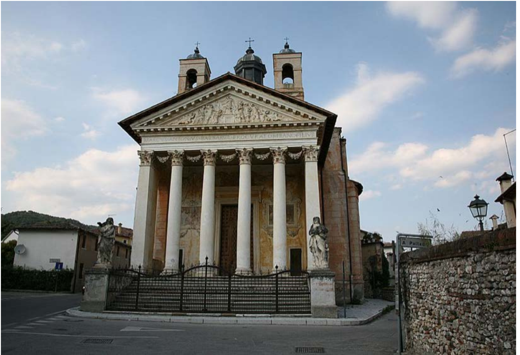
Le temple construit 10 ans après la villa se situe en dehors du domaine.
