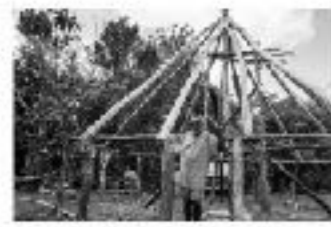
La case kanak traditionnelle est faite de bois et de cordes de fibres de palmier.
